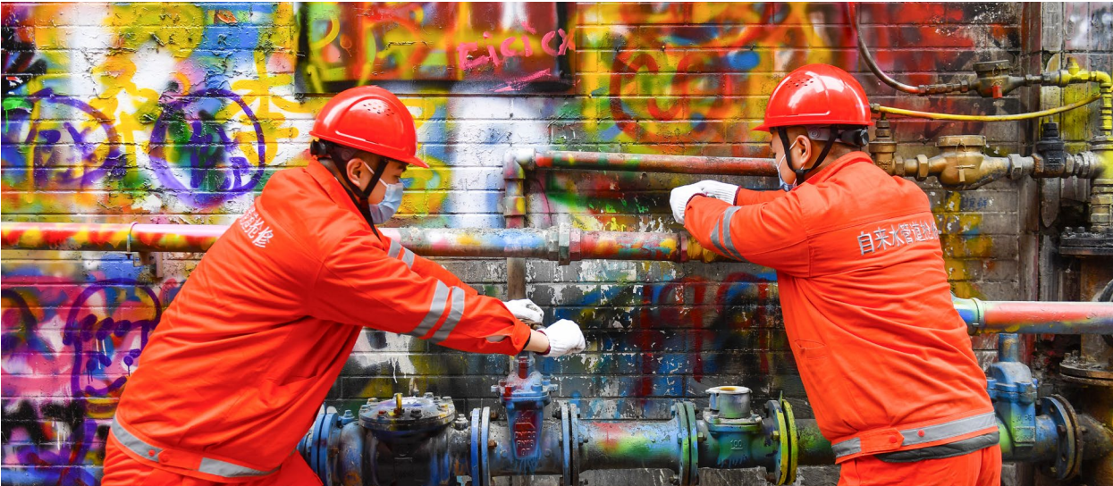
市水投集团管道维修人员坚守岗位全力保障城市供水
