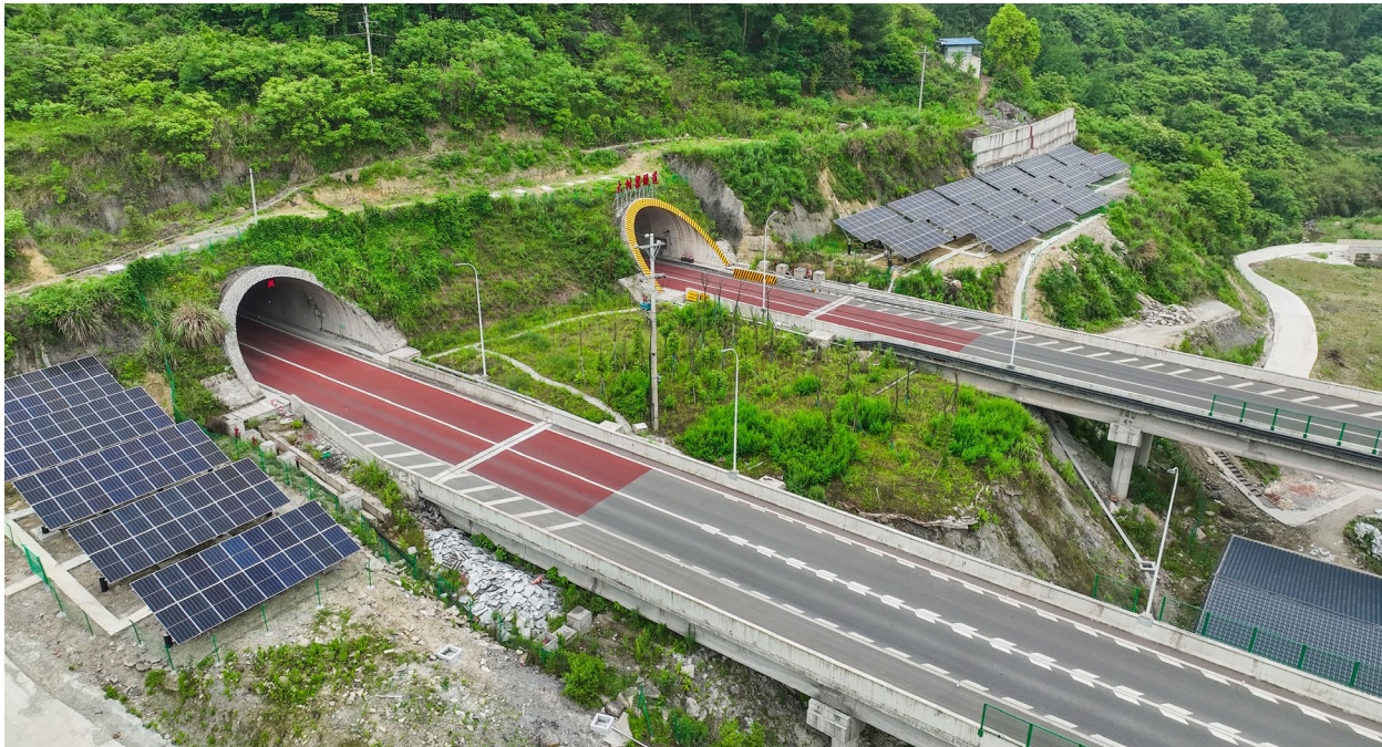
重庆高速集团运营的城开高速公路大树梁隧道光伏项目
