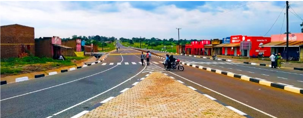
重庆交通开投集团所属外建集团利比里亚承建项目
