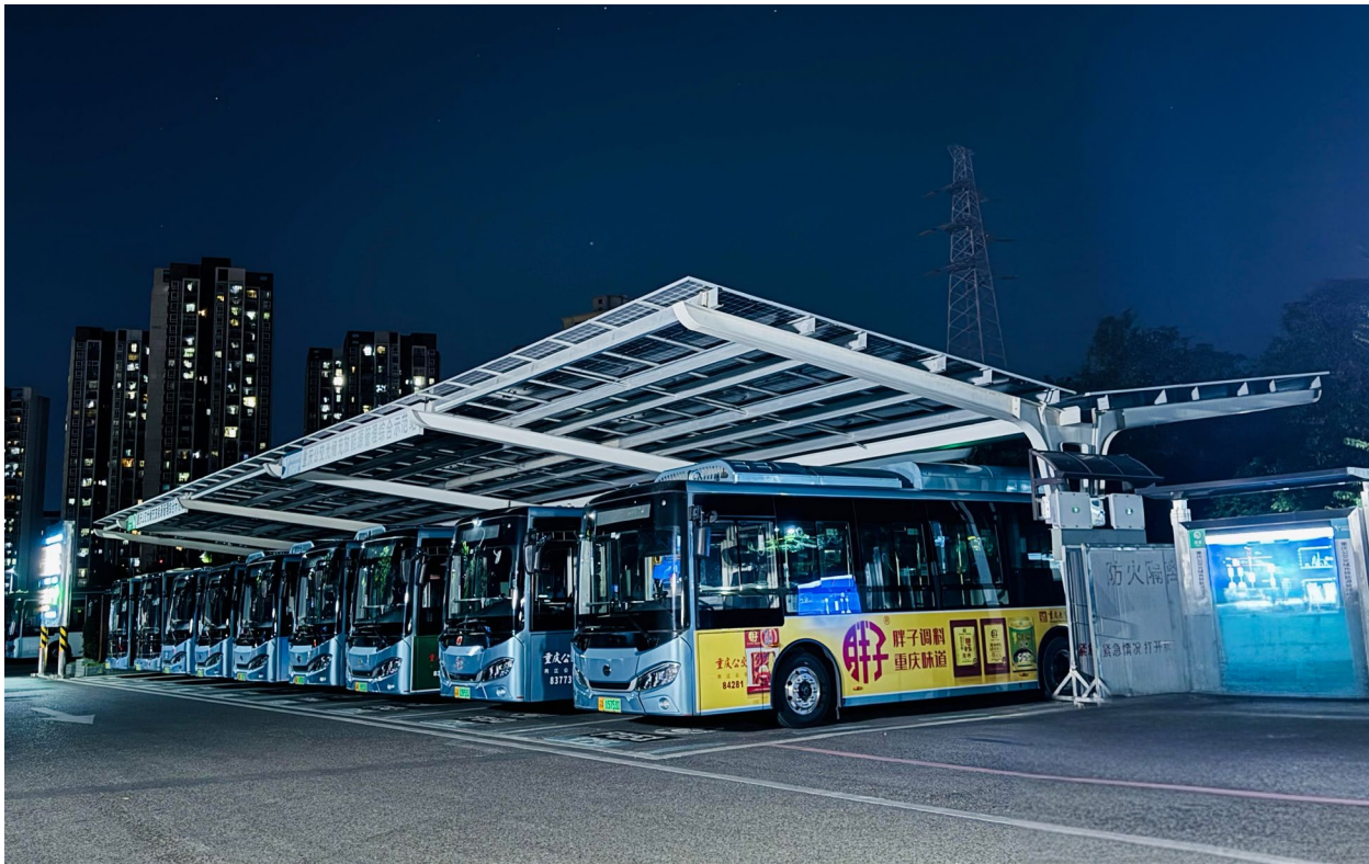
重庆交通开投集团光储充放检示范站参与重庆市首次 V2G 规模化反向放电试点应用
