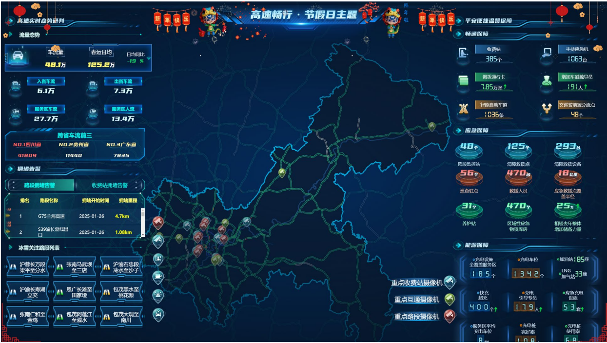
重庆高速集团路网智慧监测与应急处置平台
