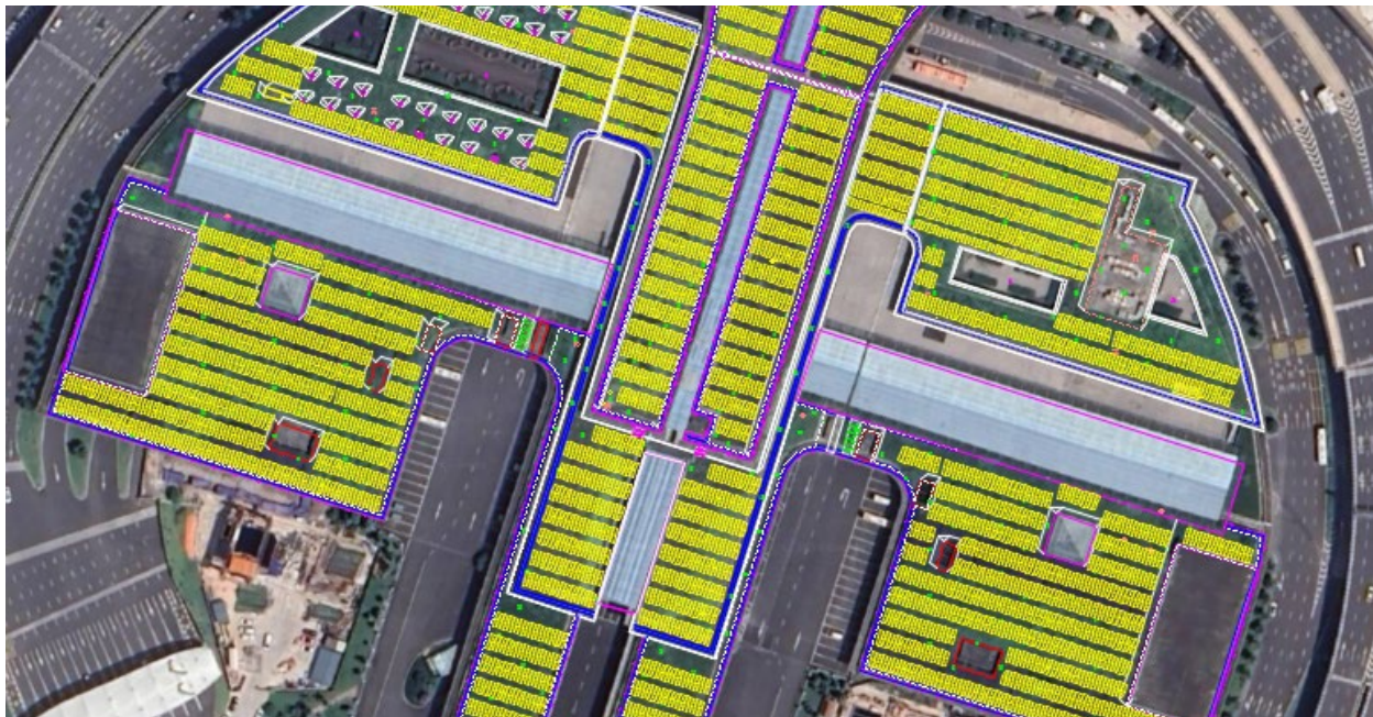
重庆机场集团光伏建设项目
