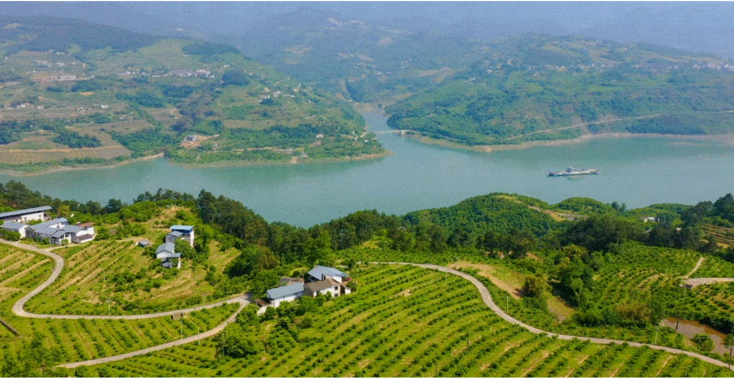
重庆地矿集团牵头设计的“长江万州区溪口段岸线生态修复项目”
