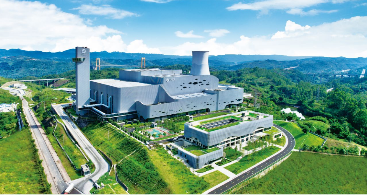
重庆水务环境集团所属三峰御临生活垃圾焚烧厂
