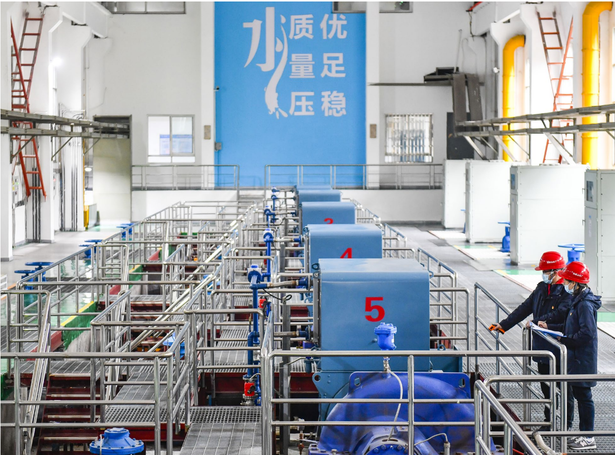
重庆水务环境集团工作人员开展巡检
